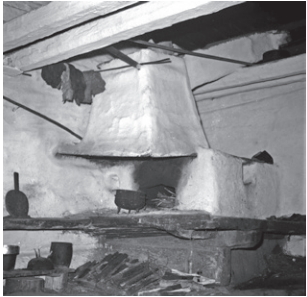
Obr. 5, 6. Vykurovacie zariadenie v obytnom dome č. 438 na pôvodnom mieste. Fotoarchív SNM v Martine, neg. č. 29 605, neg. č. 29 609. Foto J. Boďa, 1965
